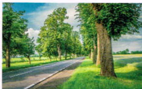
Droga z poboczem nieutwardzonym
